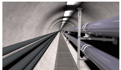
Bauherrenvertretung Hoch- und Tiefbau Neubau Fernwärmeverbindung Zürich-Nord und Zürich-West
