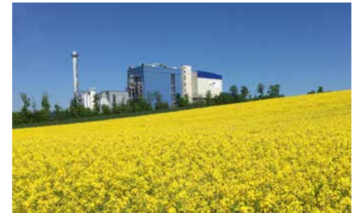
Müllverbrennungsanlage Zistersdorf (A): Energetische Analyse
