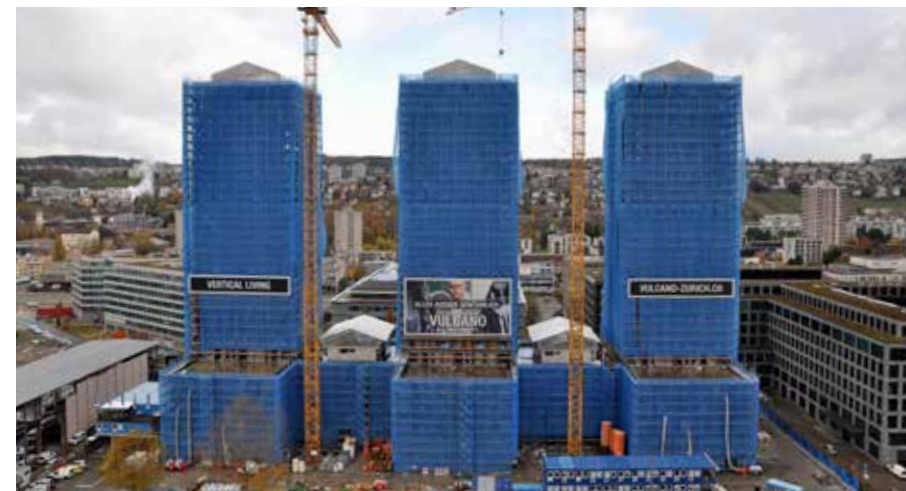
Vulcano Zürich: Bauherrenvertretung und Qualitätssicherung Gebäudetechnik
