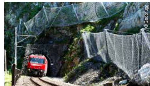
Steinschlagsimulationen für die optimale Auslegung der Geobrugg Steinschlagbarrieren RXE.
