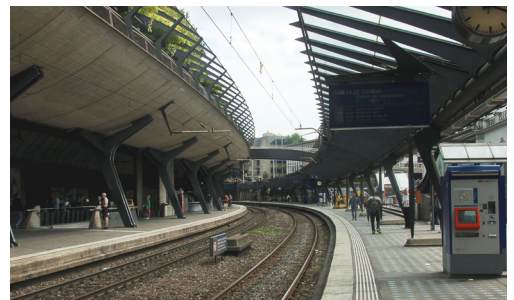
Zustandsanalyse Bahnhof Zürich Stadelhofen SBB AG
