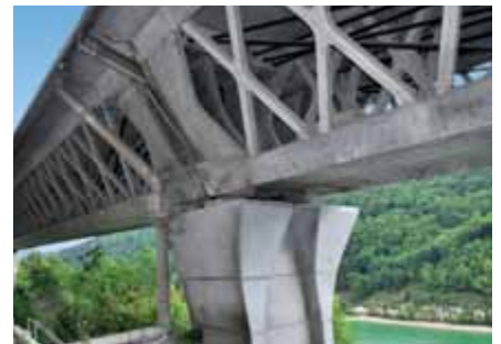
KKS Korrosionsschutz für Stütze «Viaduc de Sylans», Frankreich
