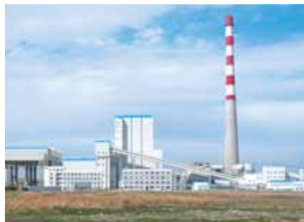
Anlage mit luftgekühlten Kondensatoren des thermischen Kraftwerks Keyouzhong (2x 300 MW), China
