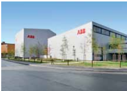
Neubau ABB Produktionsfabrik und Laborgebäude für Hochspannungsschaltanlagen; Helbling Beratung + Bauplanung plante die gesamte Gebäudetechnik
