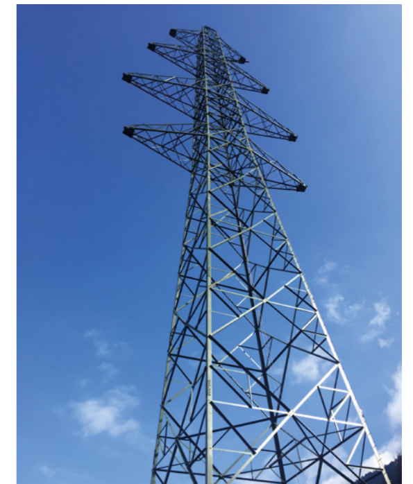
swissgrid: Unterstützung strategischer Einkauf Neubau 380kV-Leitung Châtelard-Bätiaz
